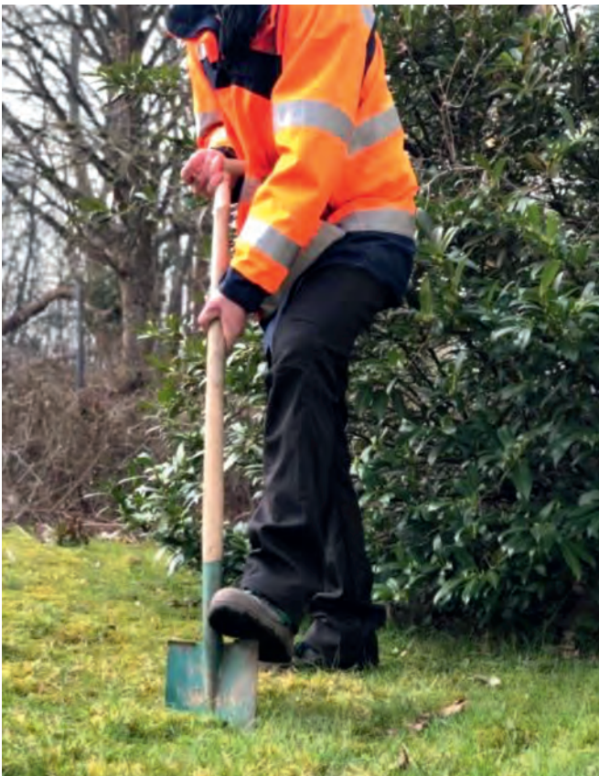
Erste Spatenstiche sind getan...
