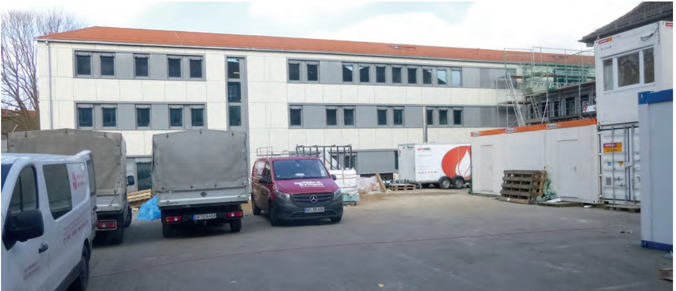
Der Ergänzungsbau der Polizeiinspektion Gifhorn an der Hindenburgstraße 2
